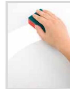
Oberflächen müssen sauber, trocken und fettfrei sein. Vorher, je nach Material entrostern, spachteln, schleifen und reinigen. Nicht zu lackierende Flächen mit Kleband und Papier überkleben, anschließend Oberflächen grundieren.
